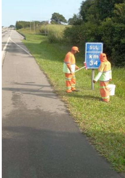
FOTO 03 – Limpeza de Placa - Km 34+000 Sul
