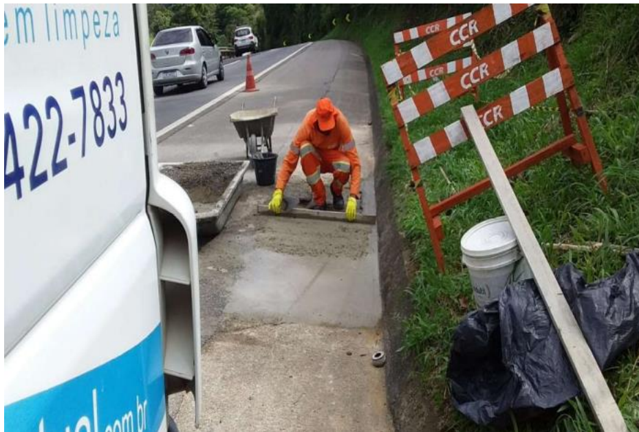
FOTO 07 – Reparo de Sarjeta - Km 2+500 Sul
