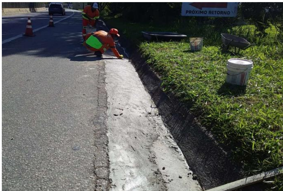
FOTO 08 – Reparo de Sarjeta Km 14+000 Sul
