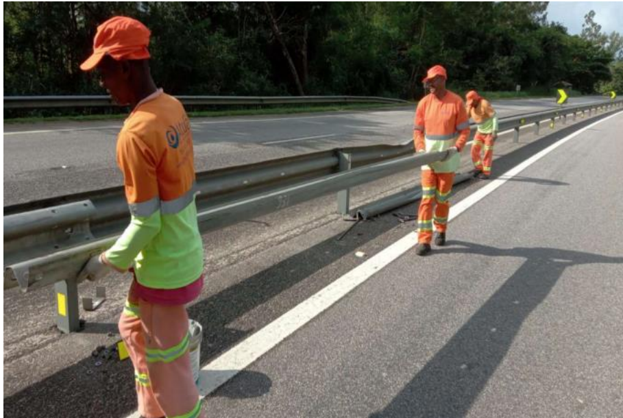
FOTO 05 – Dispositivo de Segurança - Km 18+000 Norte [2]
