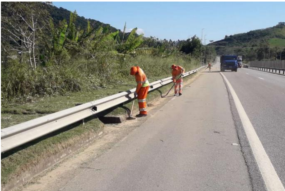
FOTO 06 – Limpeza de Sarjeta - Km 16+000 Sul
